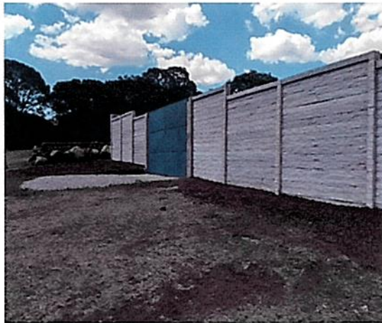
Vista exterior del Muro y Acceso
